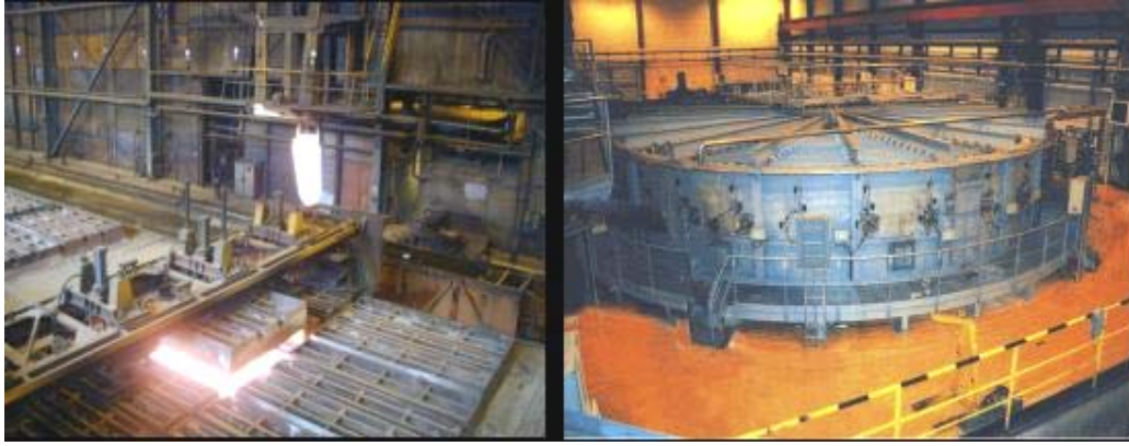
Figura 9. Ovako, fábrica Hofors, Suécia, usa oxi-combustível em 50 fornos para aumento de capacidade de produção e da flexibilidade.
